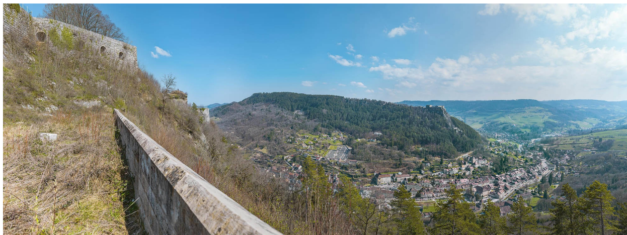
Parapet de la fausse braie (sud-est).
