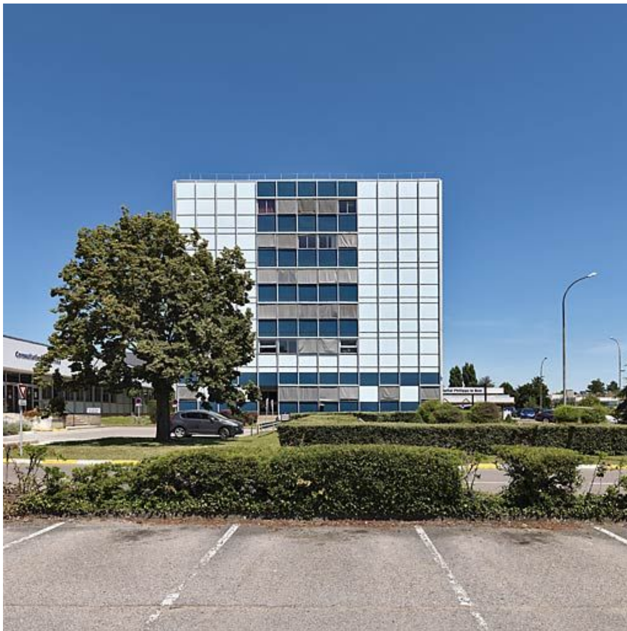
Bâtiment principal, élévation latérale.
