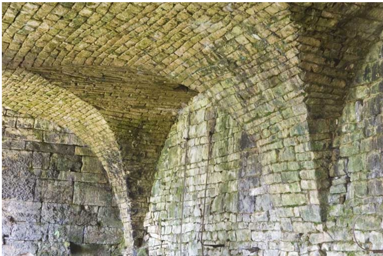
Salle des cubilots. Détail des voûtes d'arêtes.
