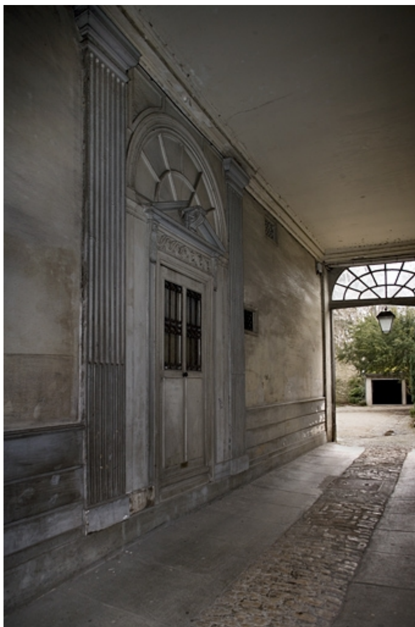
Vue de l'entrée sous le passage cocher.
