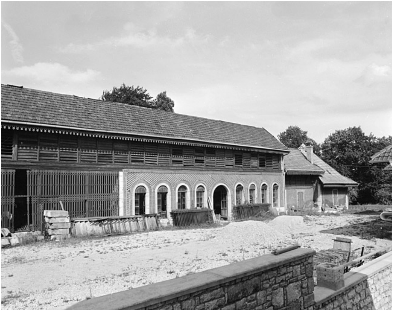
Façade sud de l'orangerie en 1981.SRI. Enquête régionale sur les bâtiments industriels (1979-1981).
