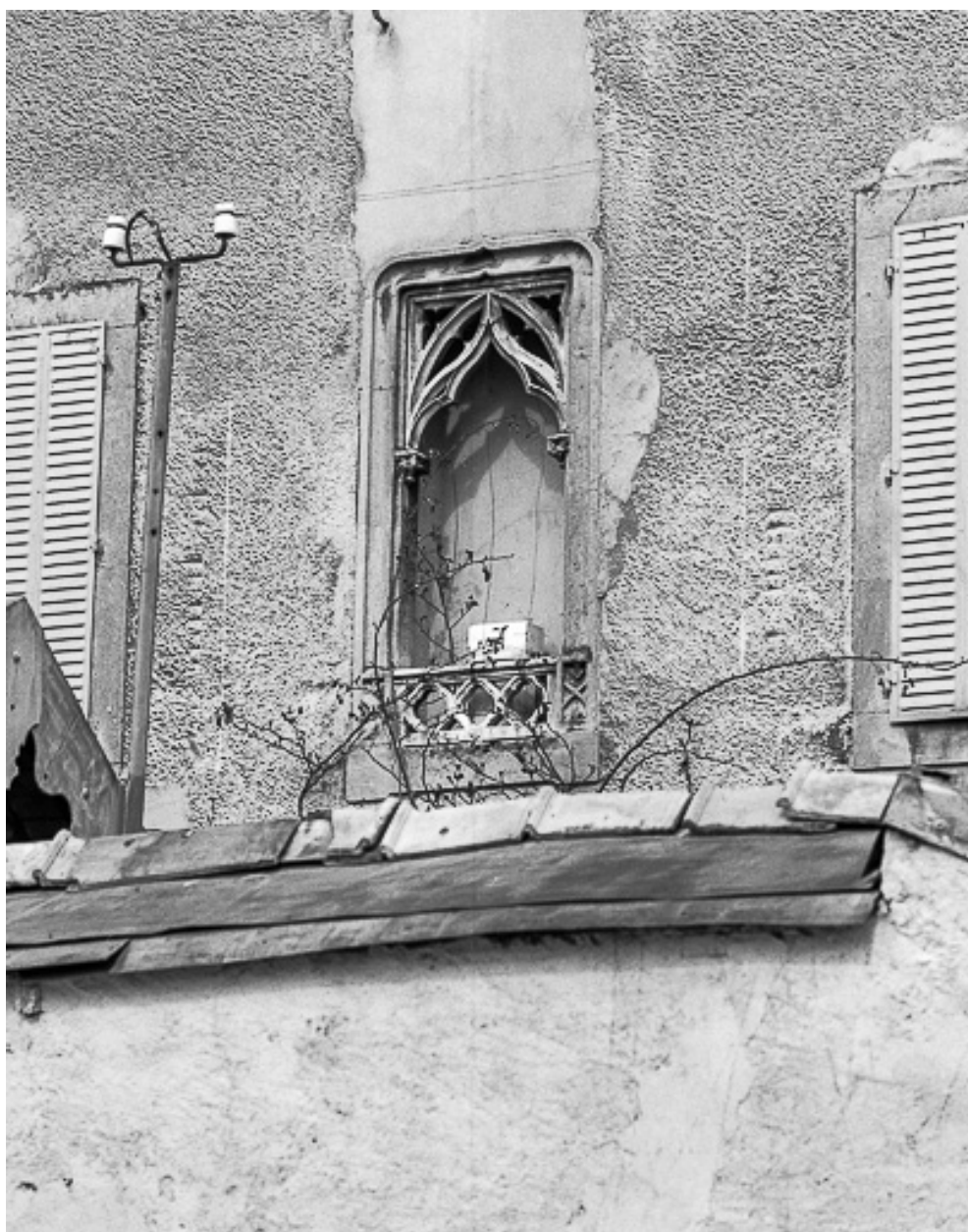
Fenêtre du pignon gauche.
