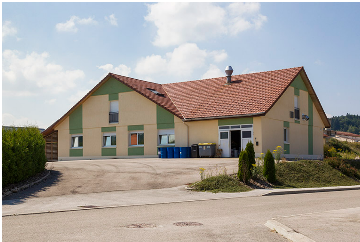
Façades postérieure et latérale gauche.
