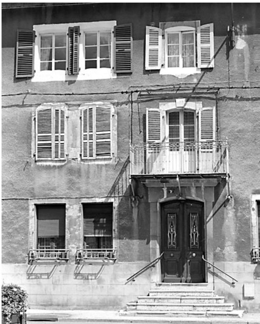
Façade antérieure : travées centrales.
