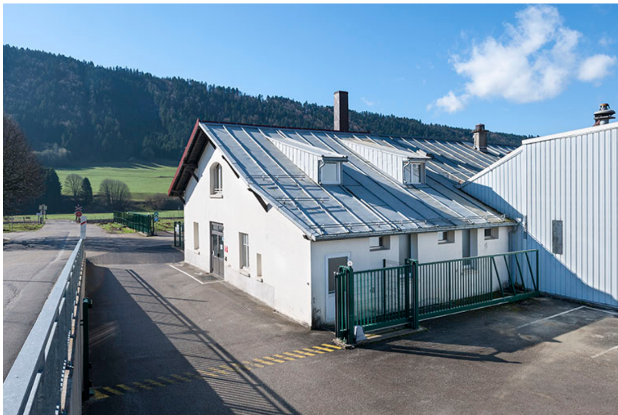
Partie sud du bâtiment originel (bureaux).
