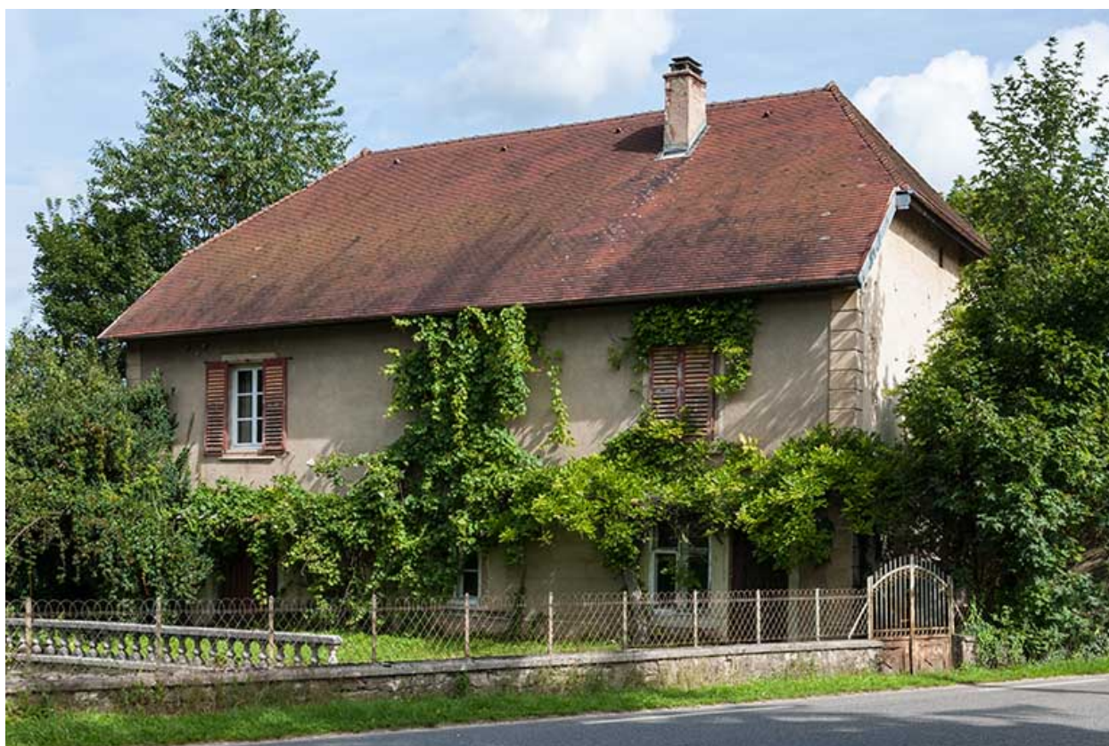
Façade sud : le logement.
