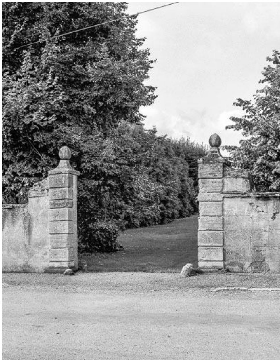
Portail d'entrée principal.
