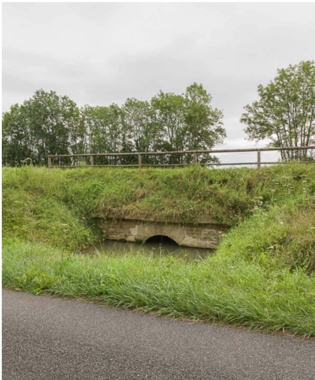
Vue de l'aqueduc.
