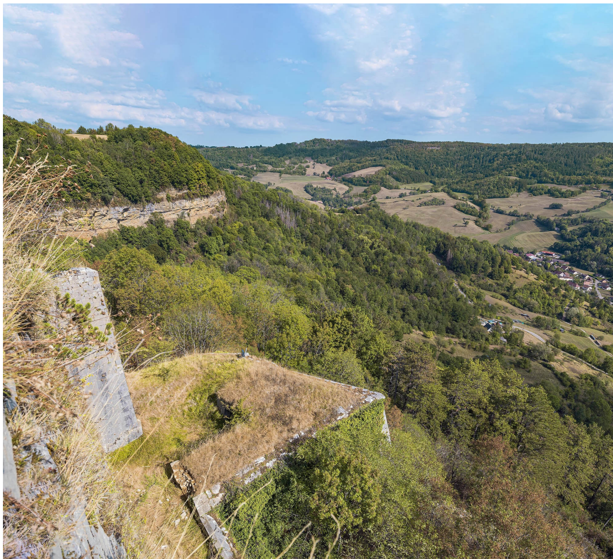
Vestige de l'ouvrage à cornes.
