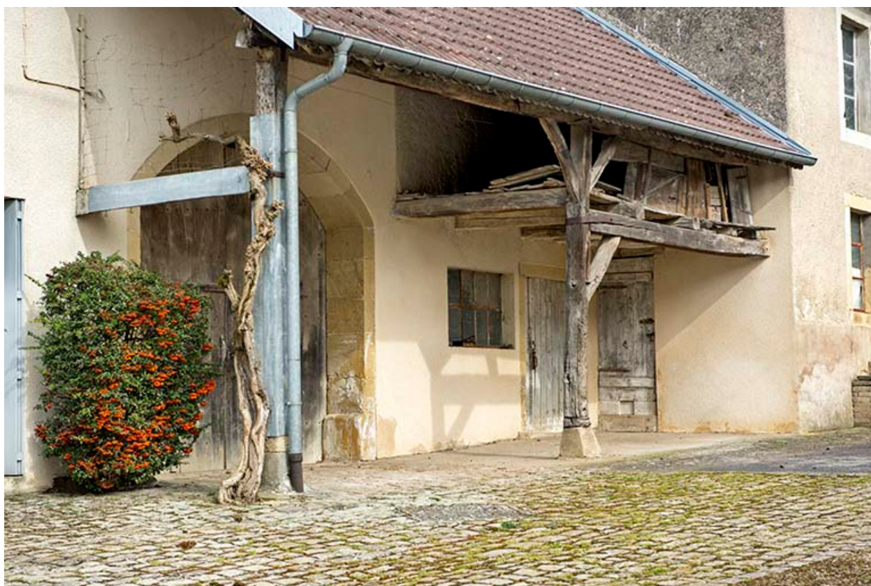
Auvent protégeant l'entrée de la grange.
