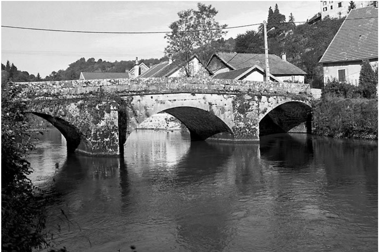
Vue depuis l'amont.
