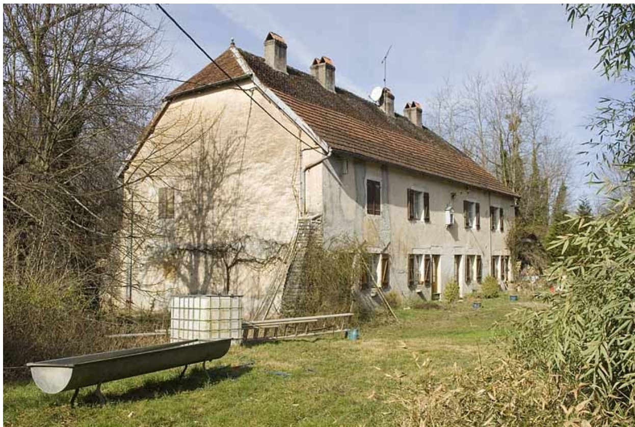
Logement d'ouvriers. Vue de trois quarts.
