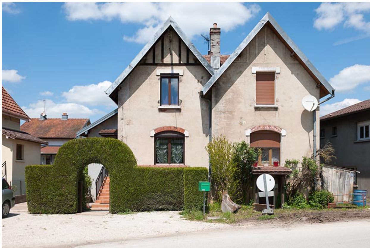
Façade antérieure d'une maison jumelée.
