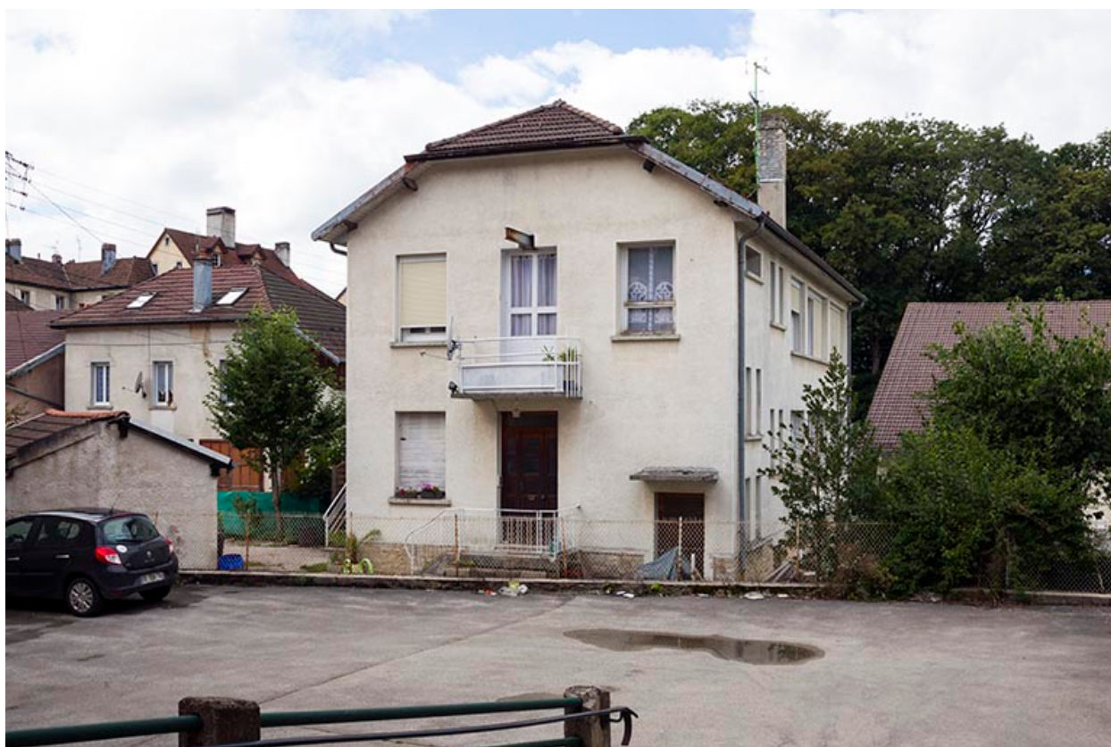
Façade latérale droite.
