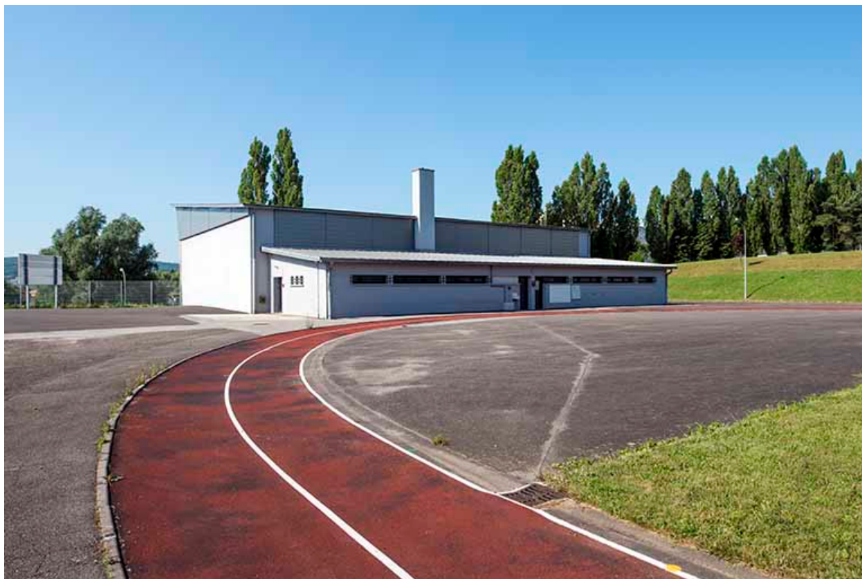
Angle nord-est du gymnase.
