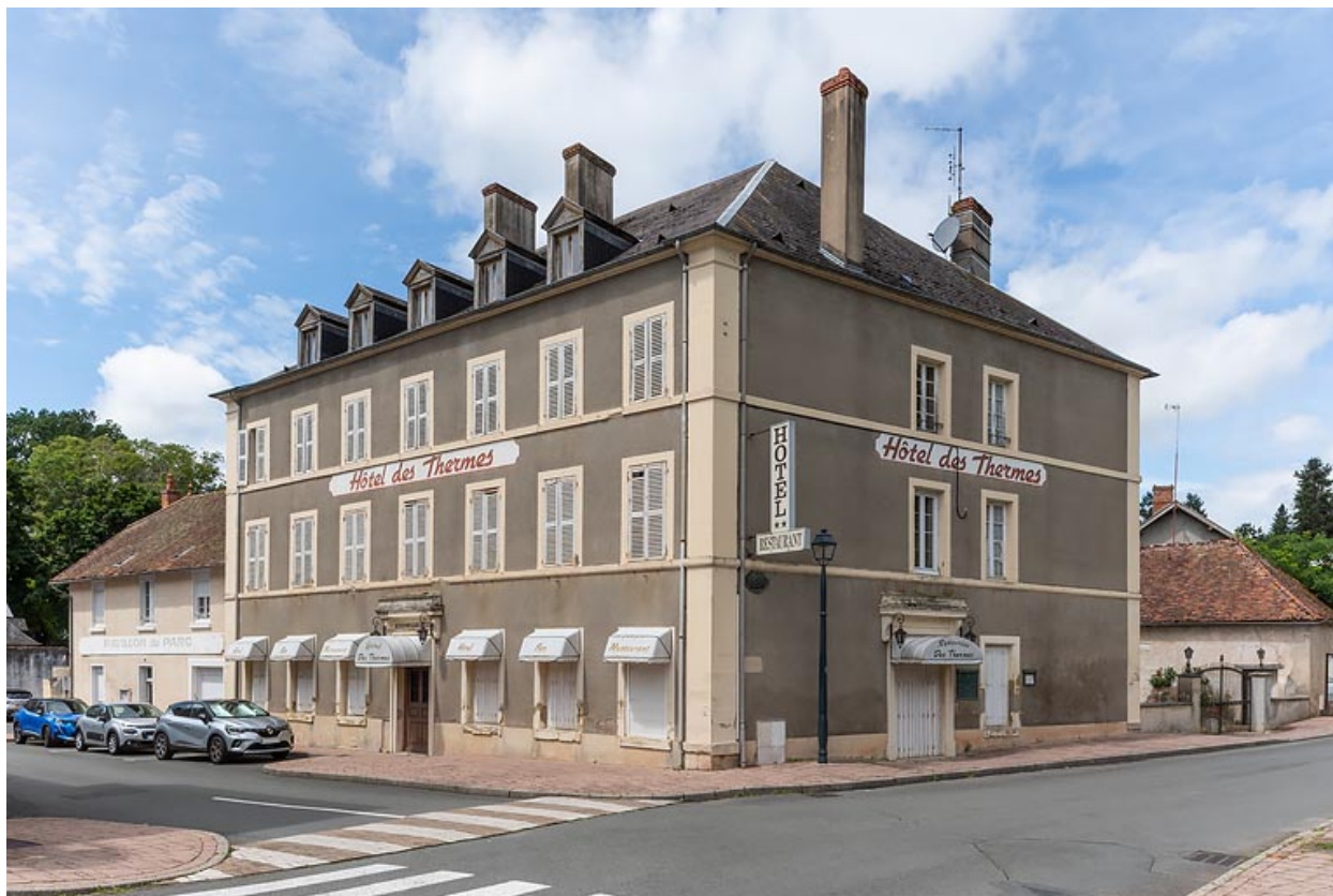
Façade sud et façade est.
