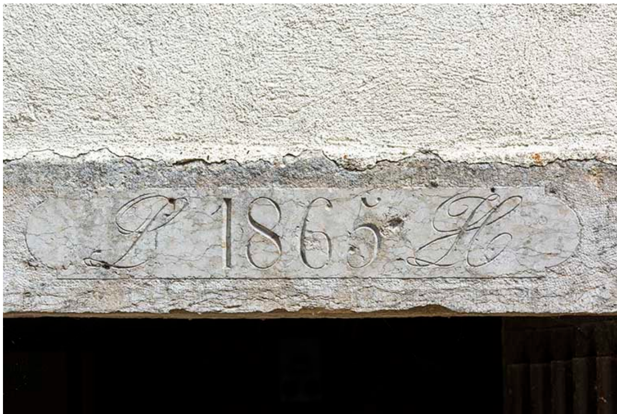
Forge (façade ouest) : linteau daté.
