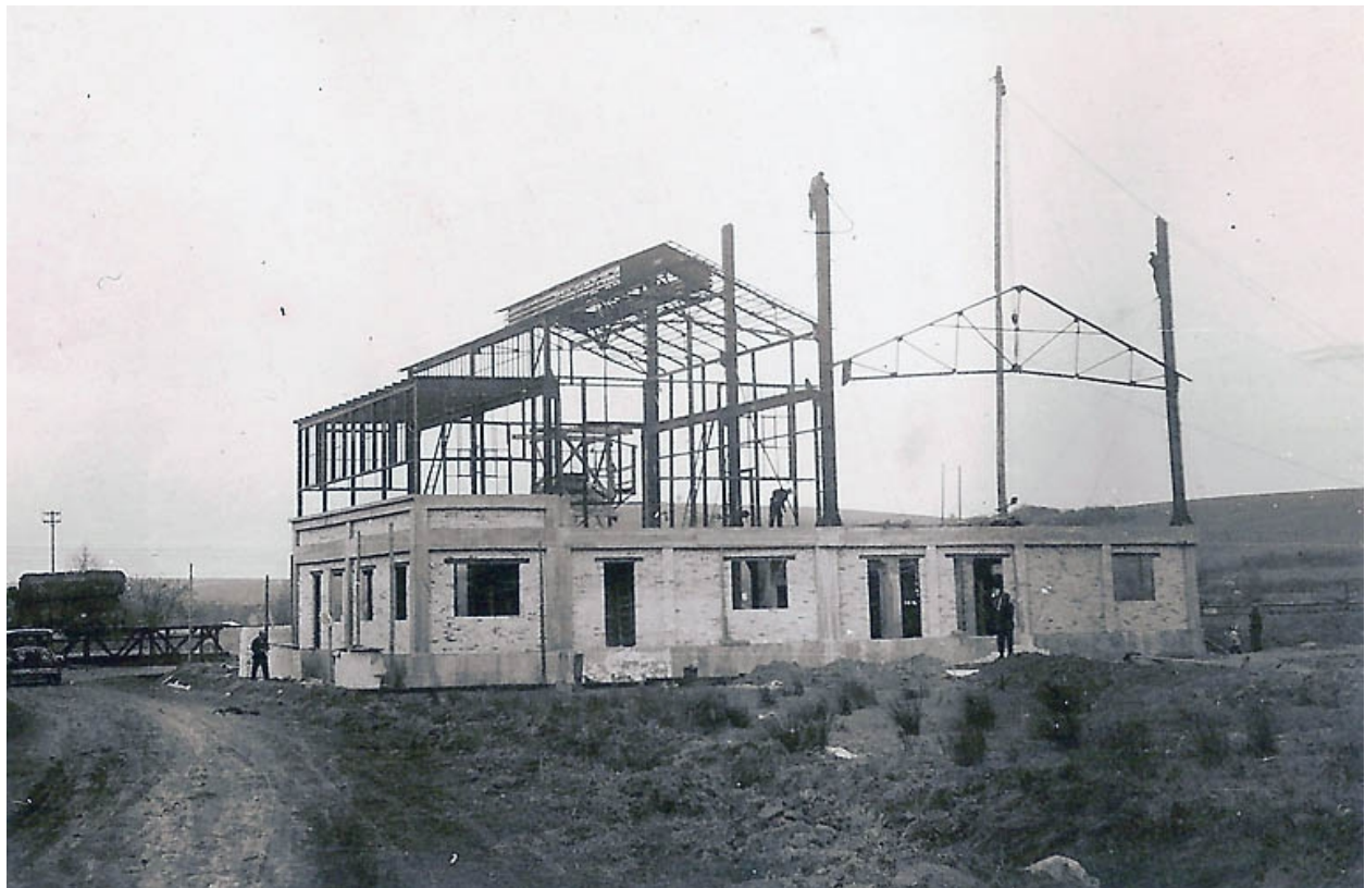
La centrale électrique en construction.
