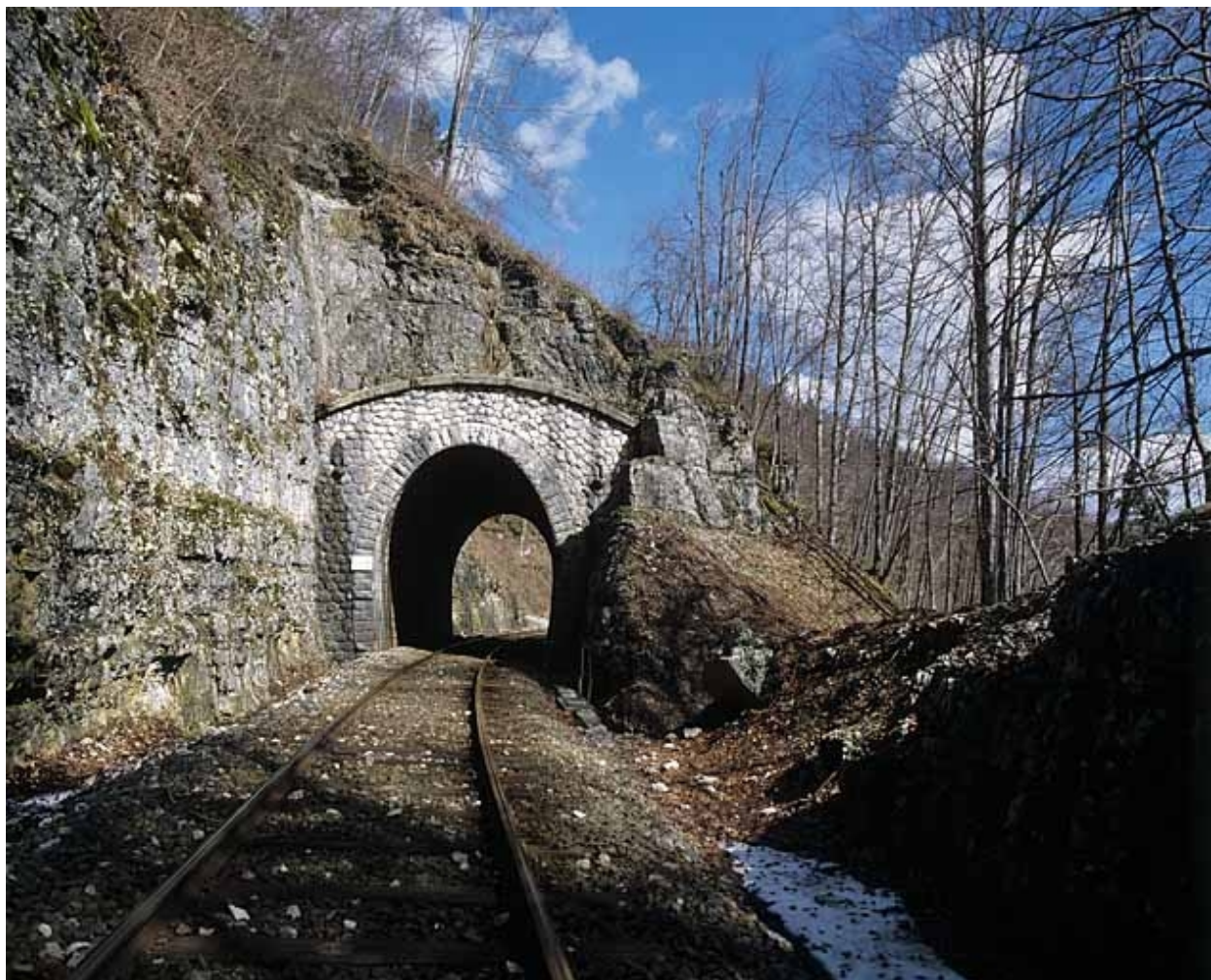
Vue d'ensemble, côté La Cluse (sud).
