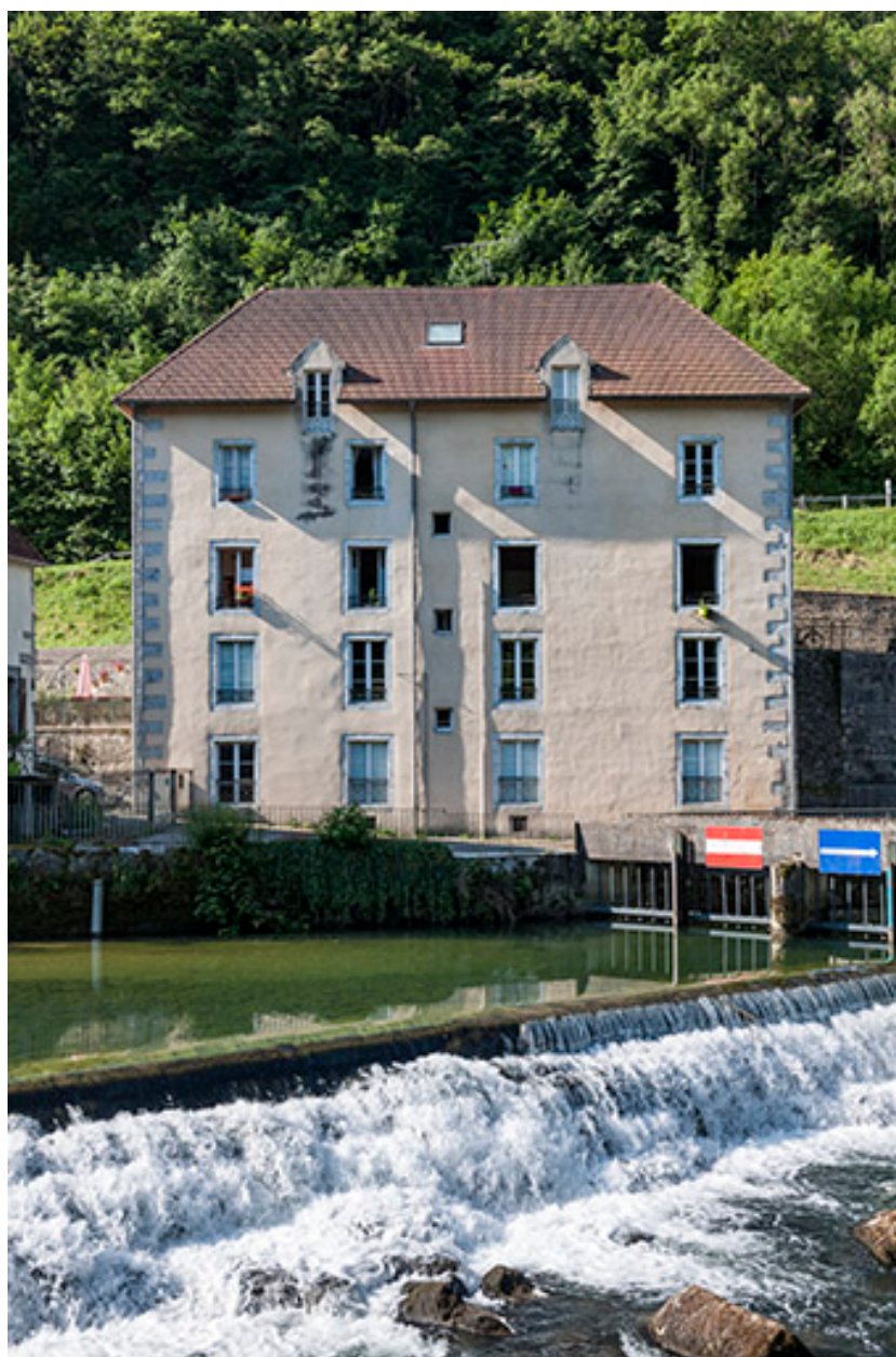
Façade nord d'un logement d'ouvriers.
