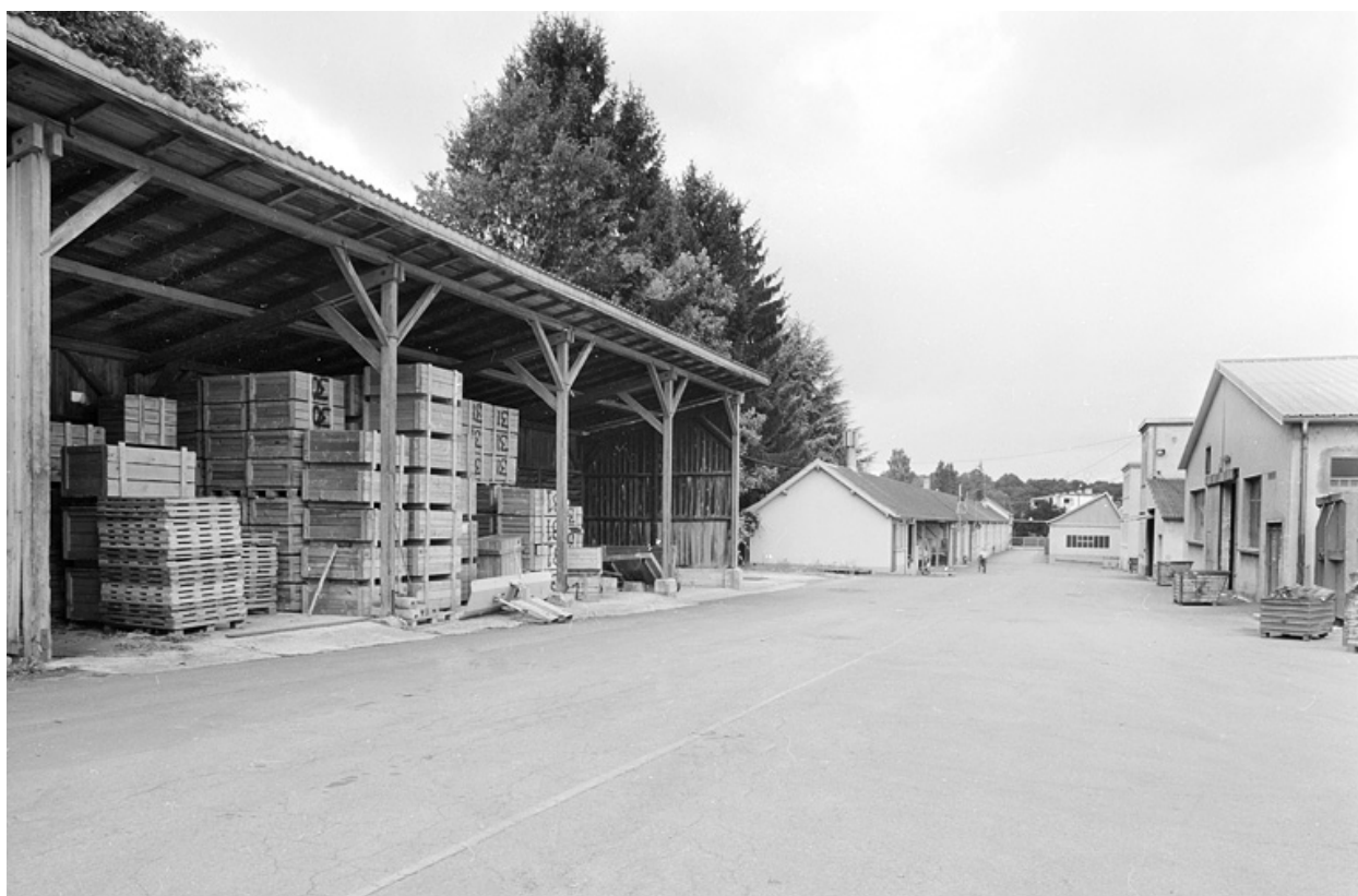
Entrepôt industriel et ateliers divers au sud.
