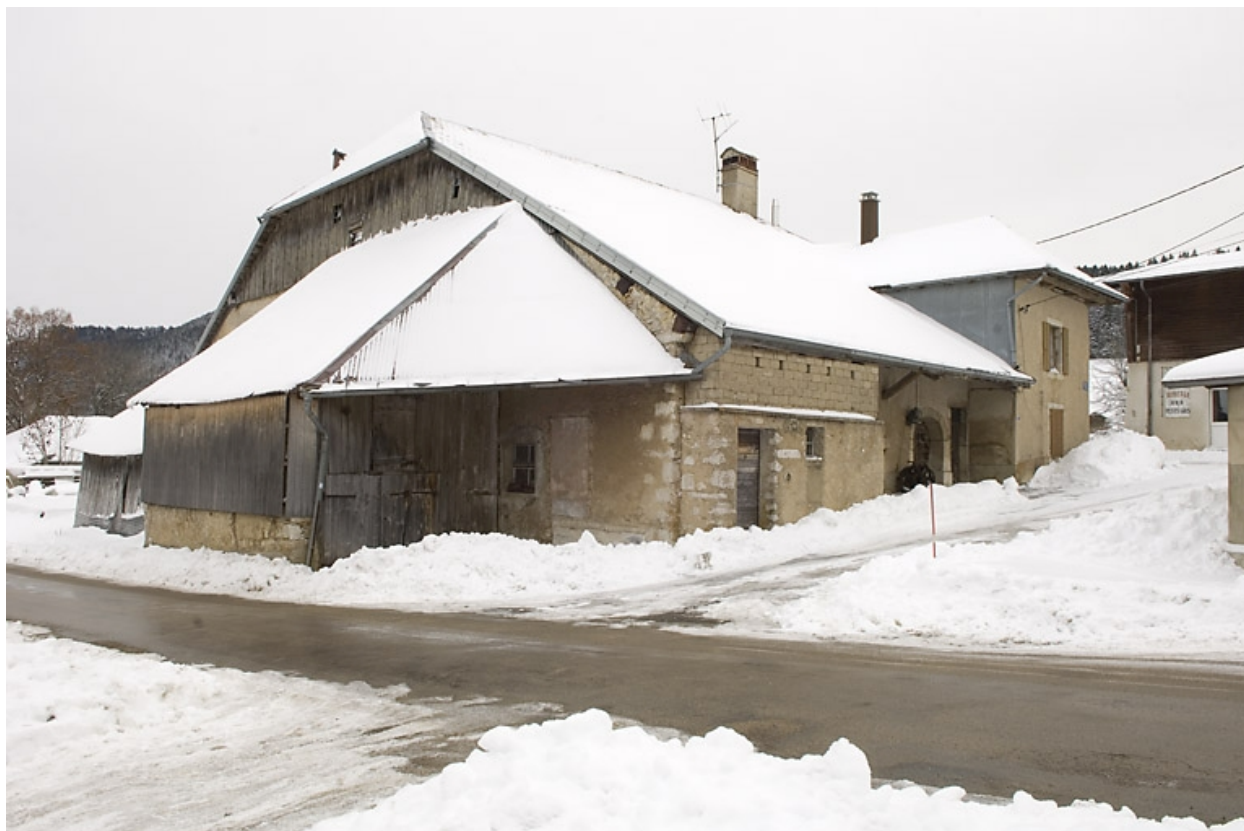
Façades antérieure et latérale gauche.
