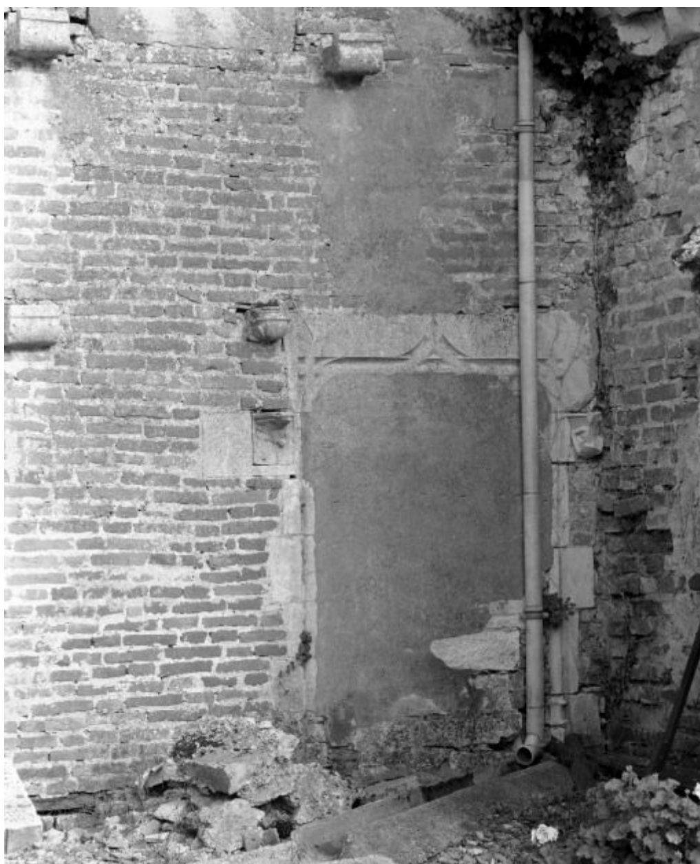
Chapelle seigneuriale, porte du mur antérieur
