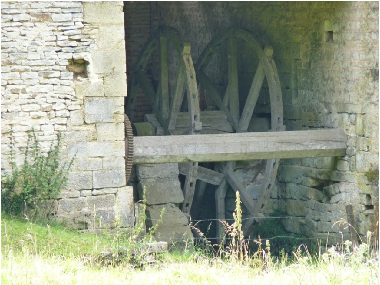
Détail de la roue du moulin, toujours en place mais effondrée.
