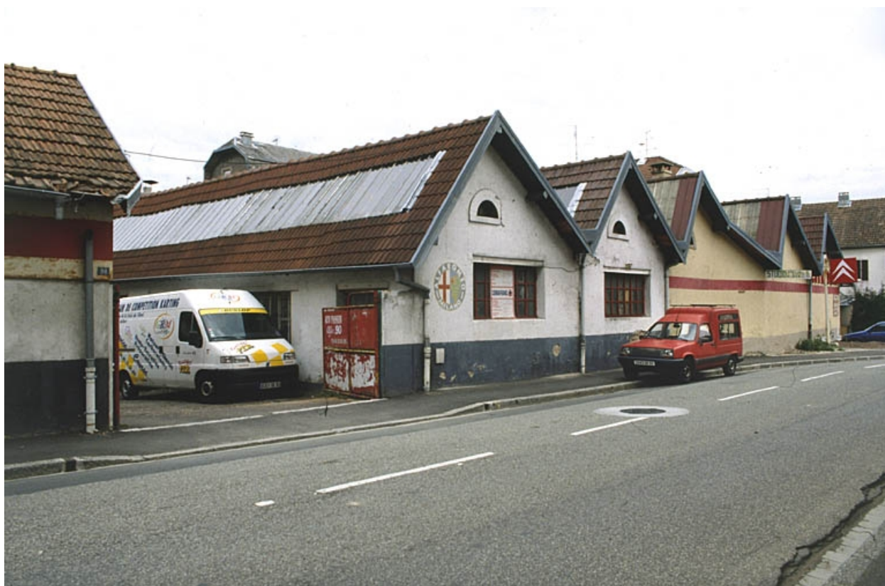
Pignons des ateliers depuis le nord-ouest.
