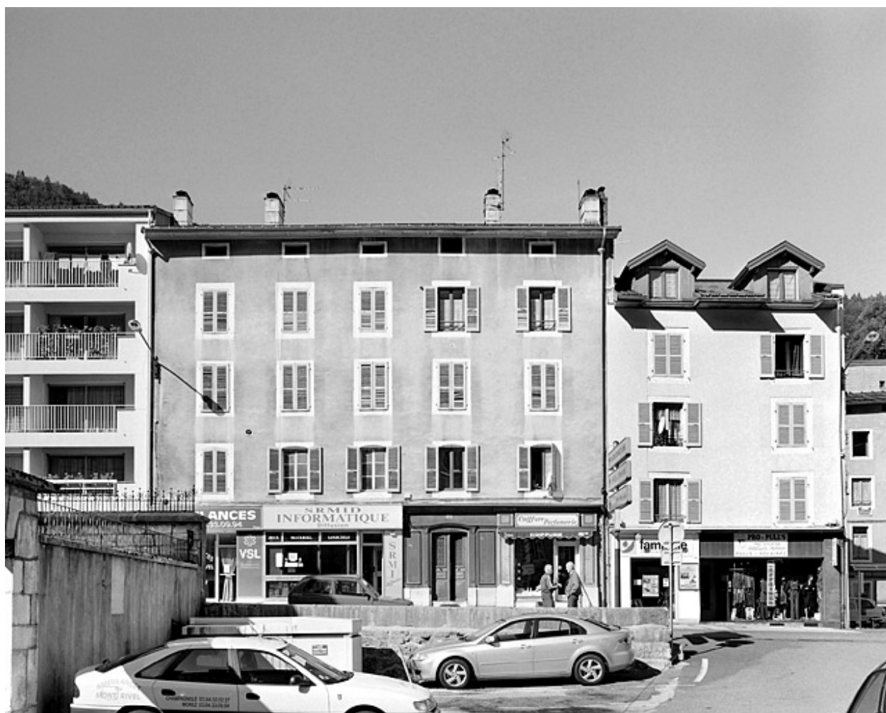
Vue d'ensemble de l'élévation antérieure.
