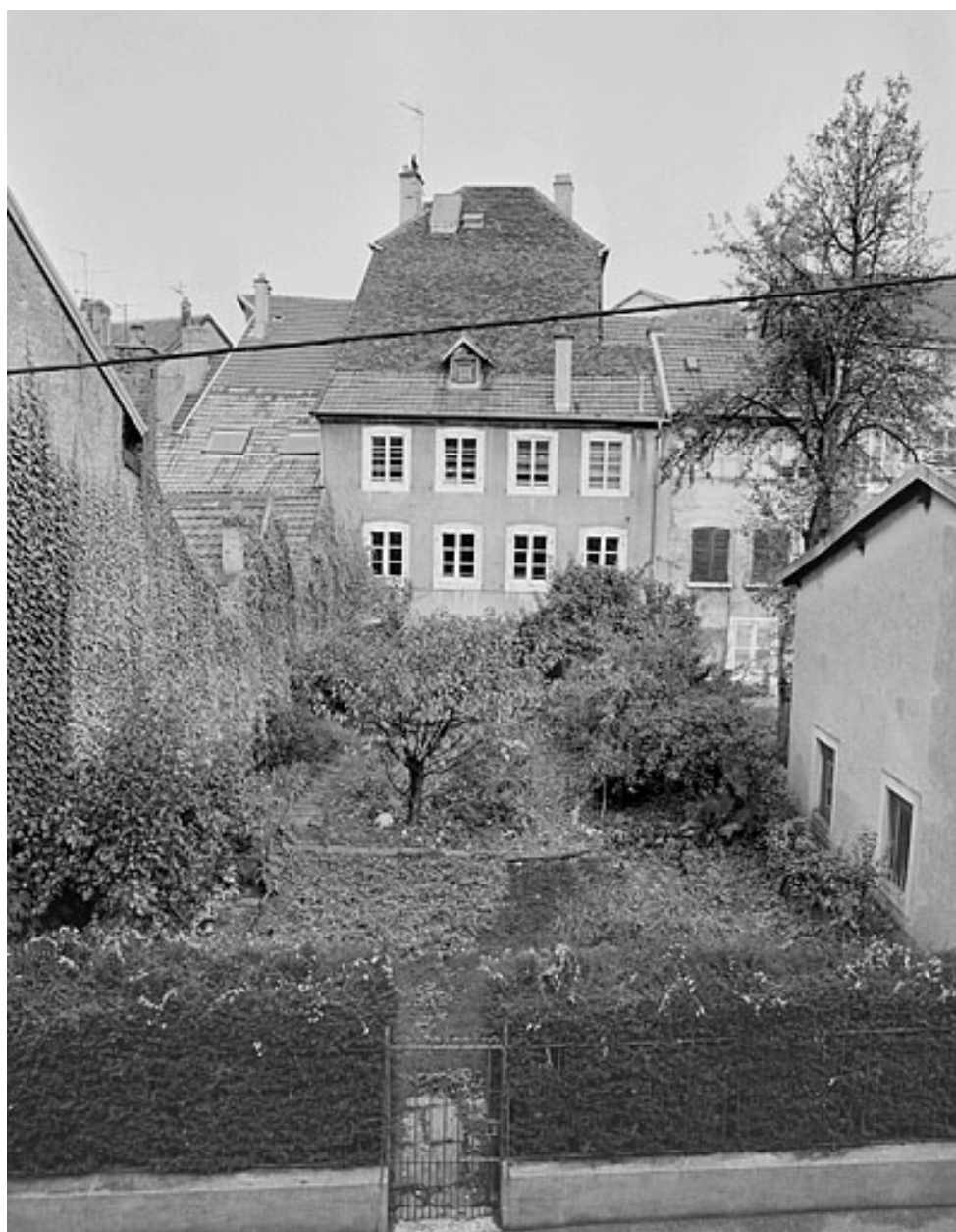
Façade postérieure et jardin.
