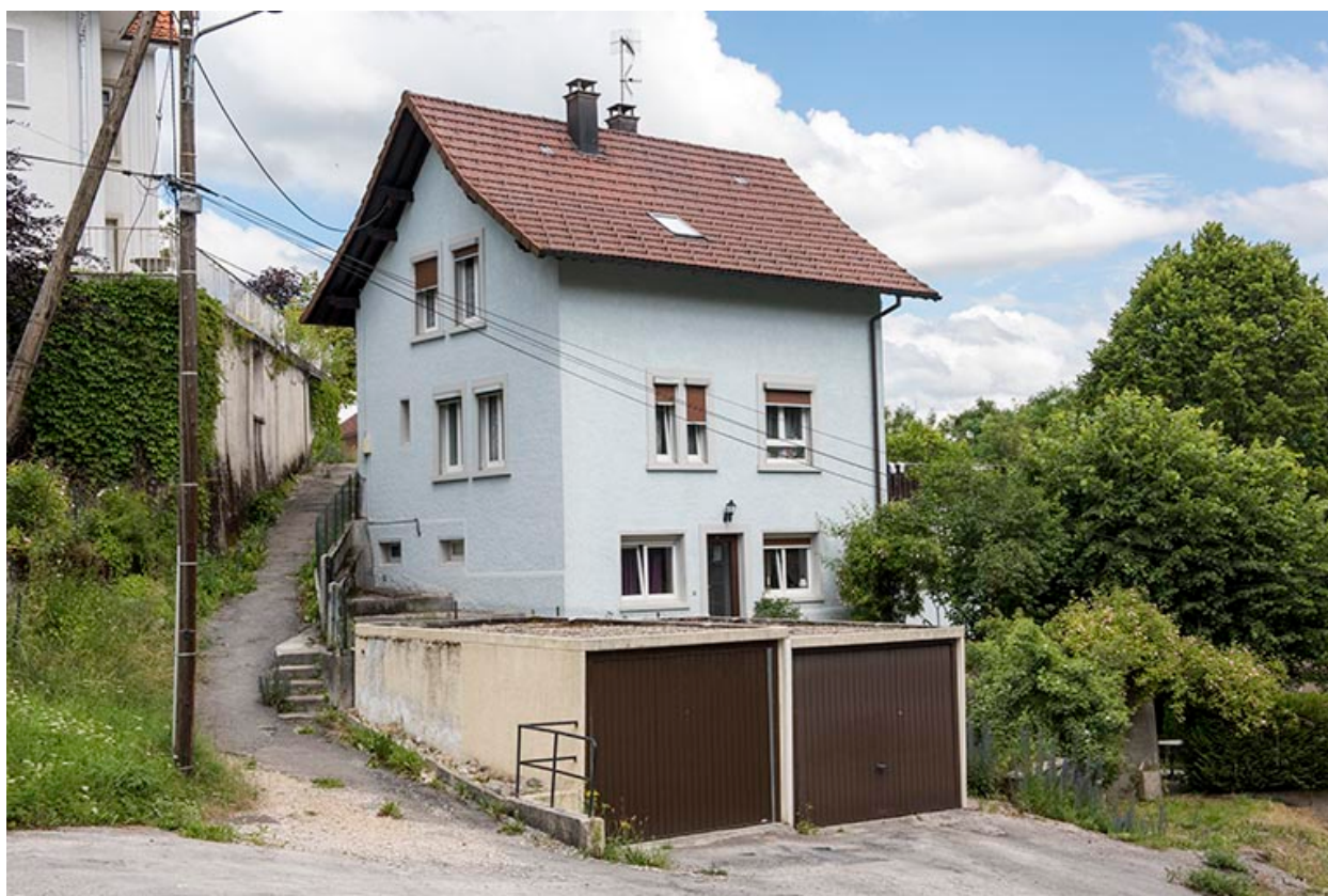
Maison : façades postérieure et latérale droite.
