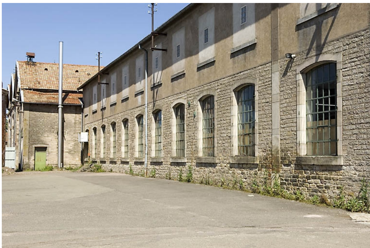
Elévation sur rue de l'atelier de préparation.
