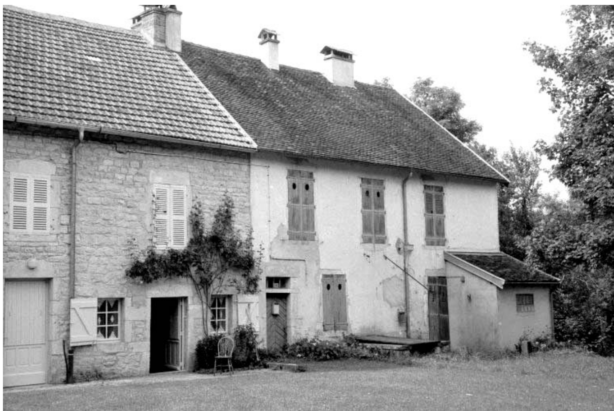
Façade postérieure du logement.
