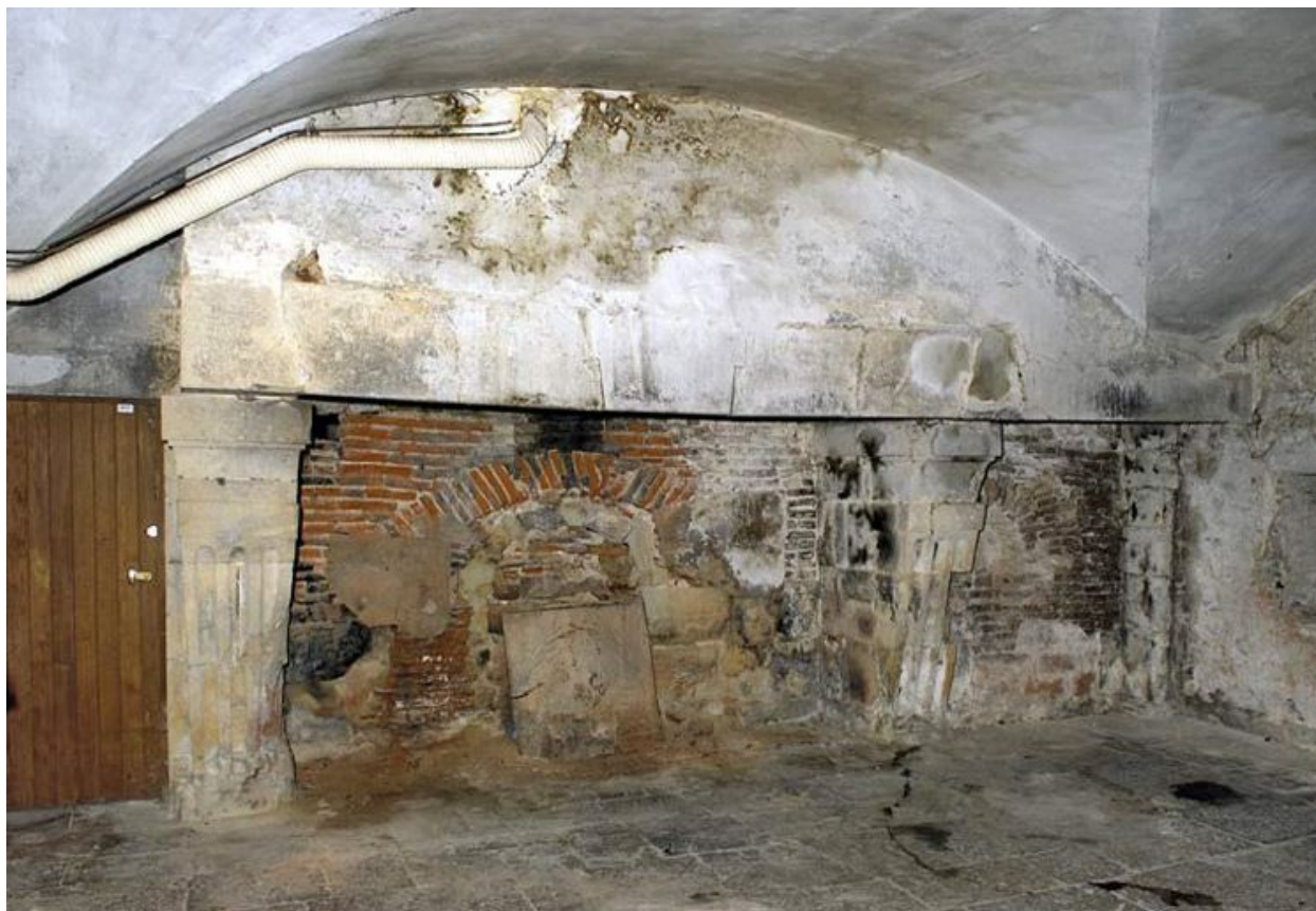
Ancien hôtel du gouverneur : sous-sol, cheminée.
