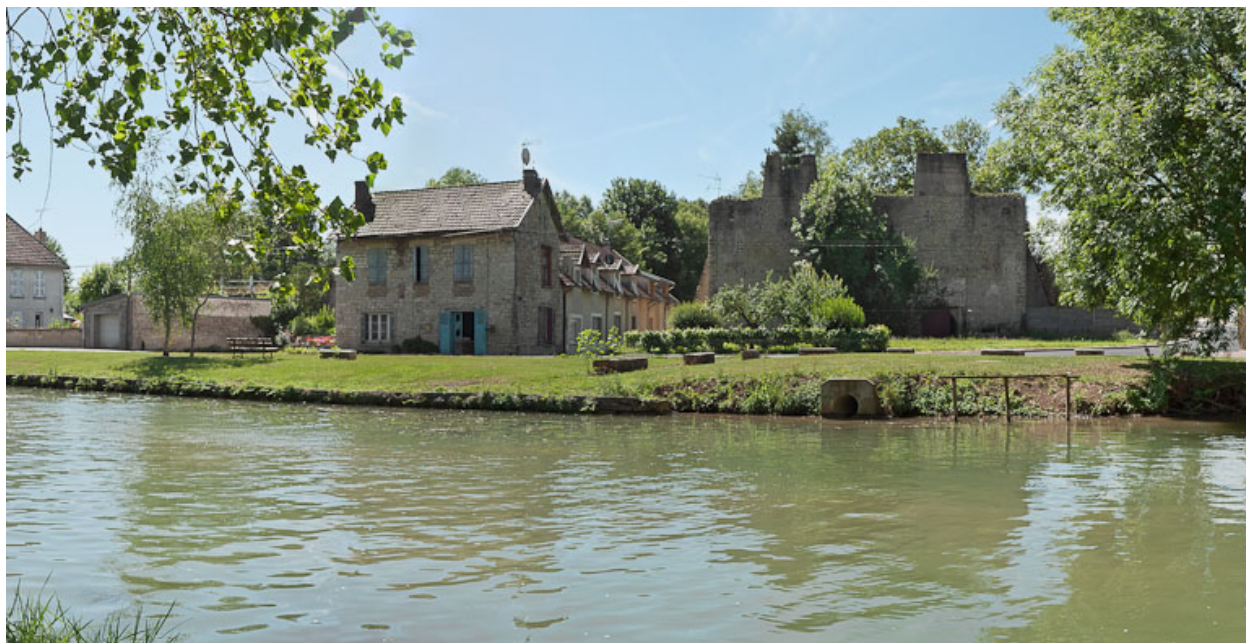
Vue générale du site depuis le canal.
