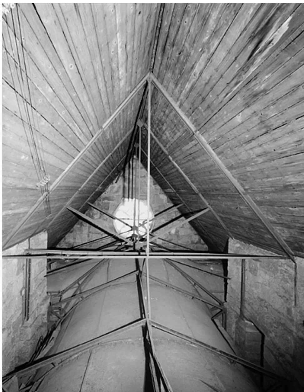
Charpente du transept.
