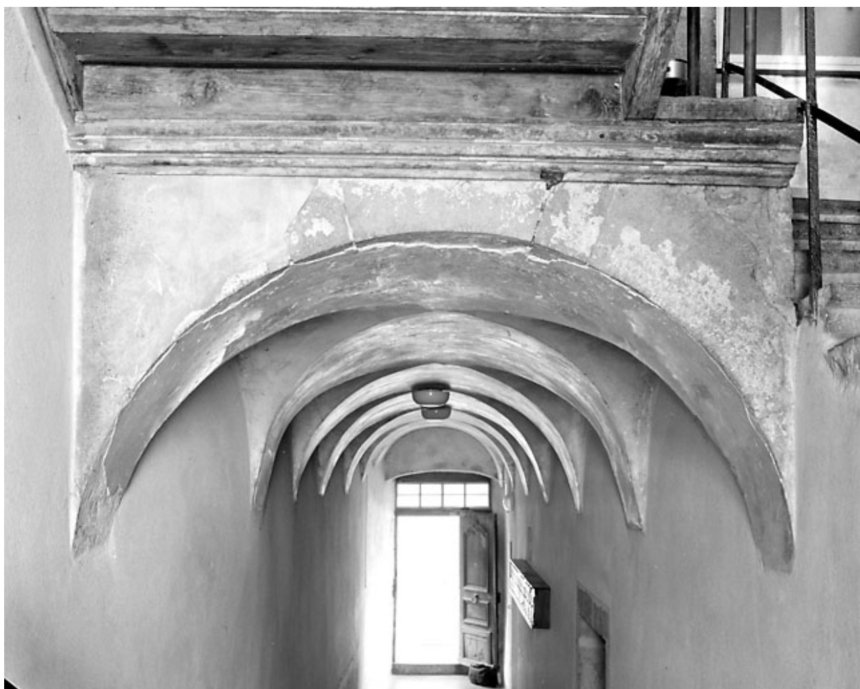
Voûte d'arêtes du couloir.
