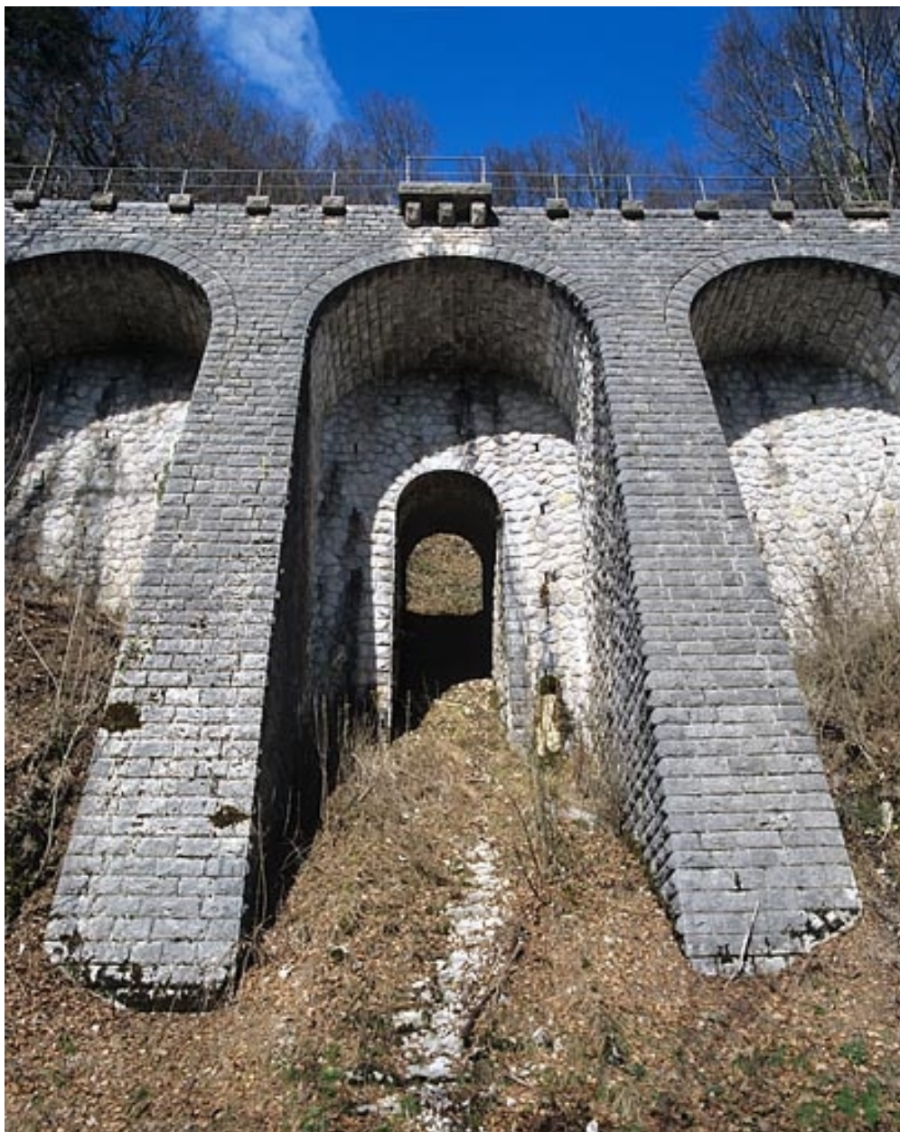
Arcade centrale, avec refuge et pont.
