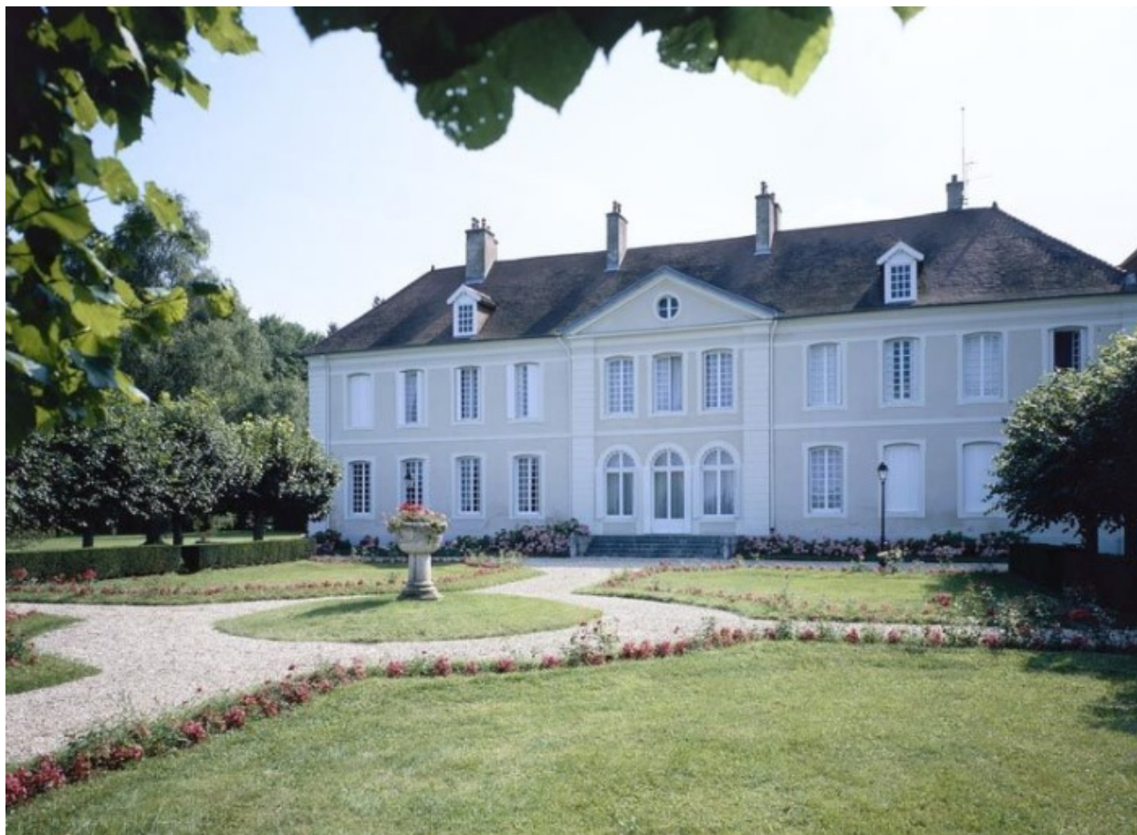
Façade sur Saône.
