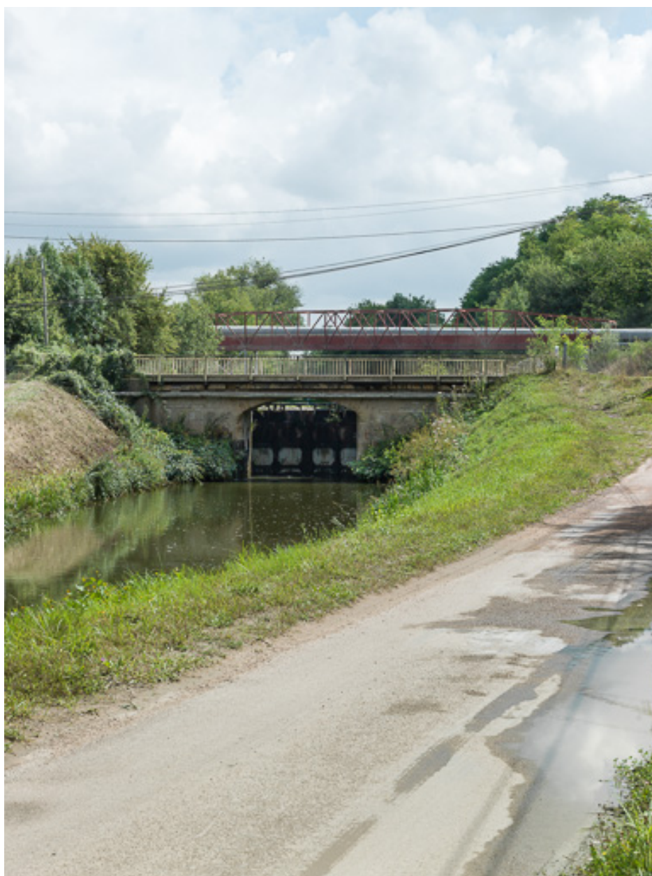
Vue d'ensemble du pont.
