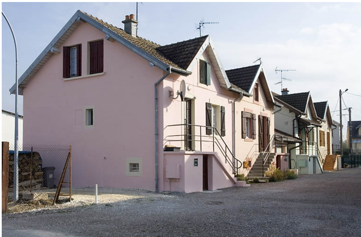
Logements doubles. Vue en enfilade depuis l'ouest.
