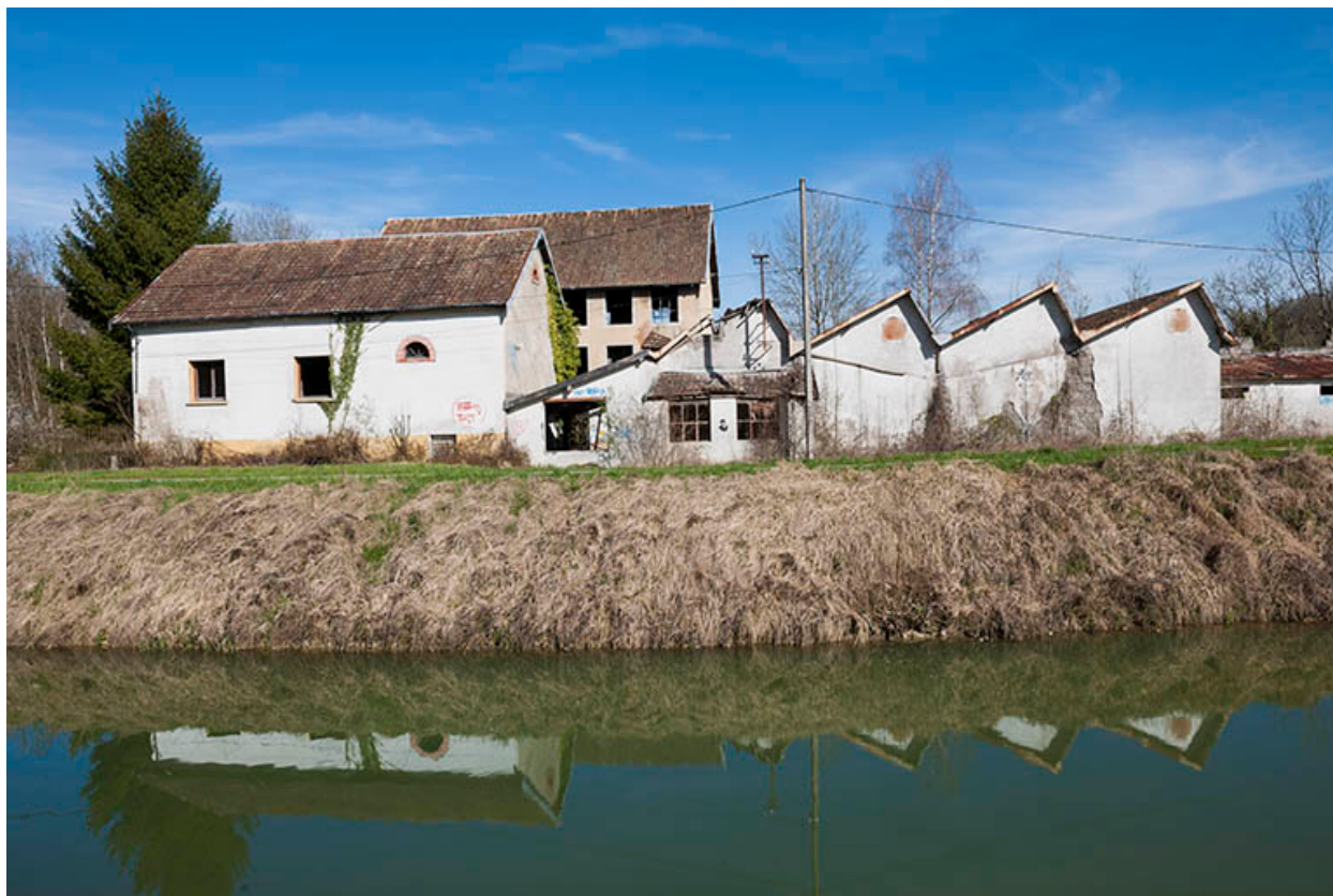
Façades sud de l'usine.
