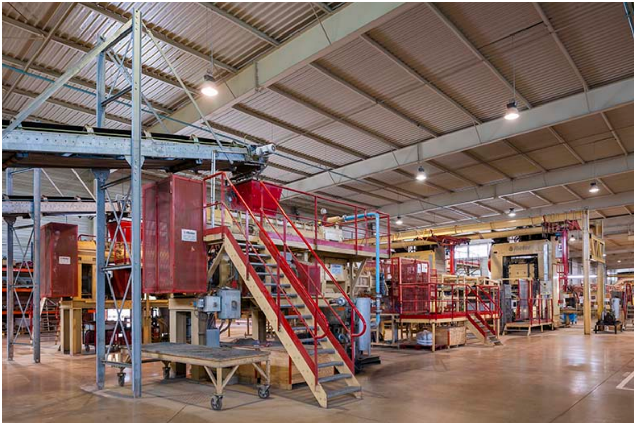
Unité de fabrication dite UL 5. Vue d'ensemble.
