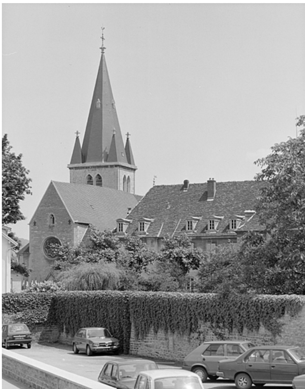
Eglise Saint-Désiré, vue générale depuis l'ouest.
