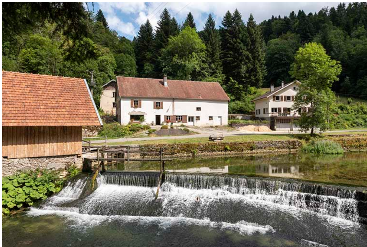
Vue d'ensemble depuis l'ouest (rive gauche).
