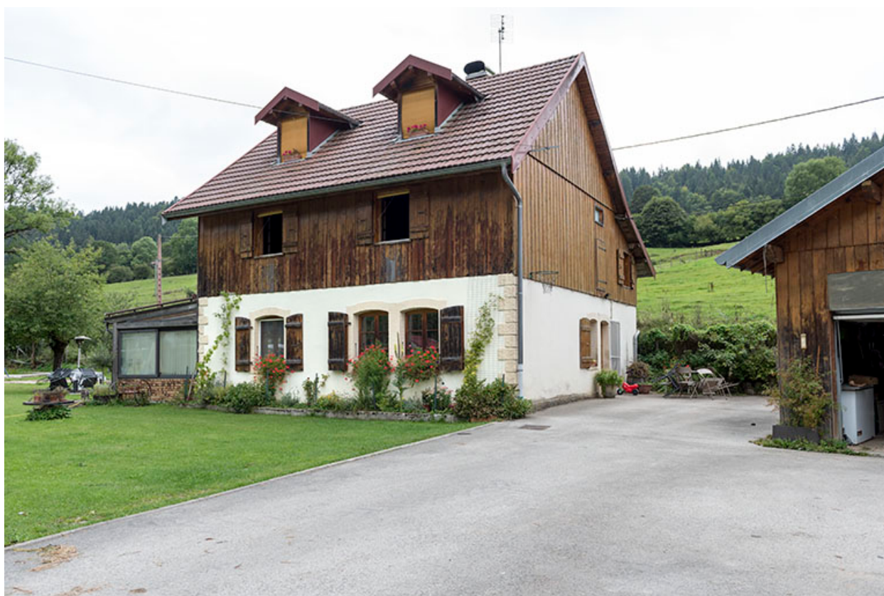
Façades antérieure et latérale droite.
