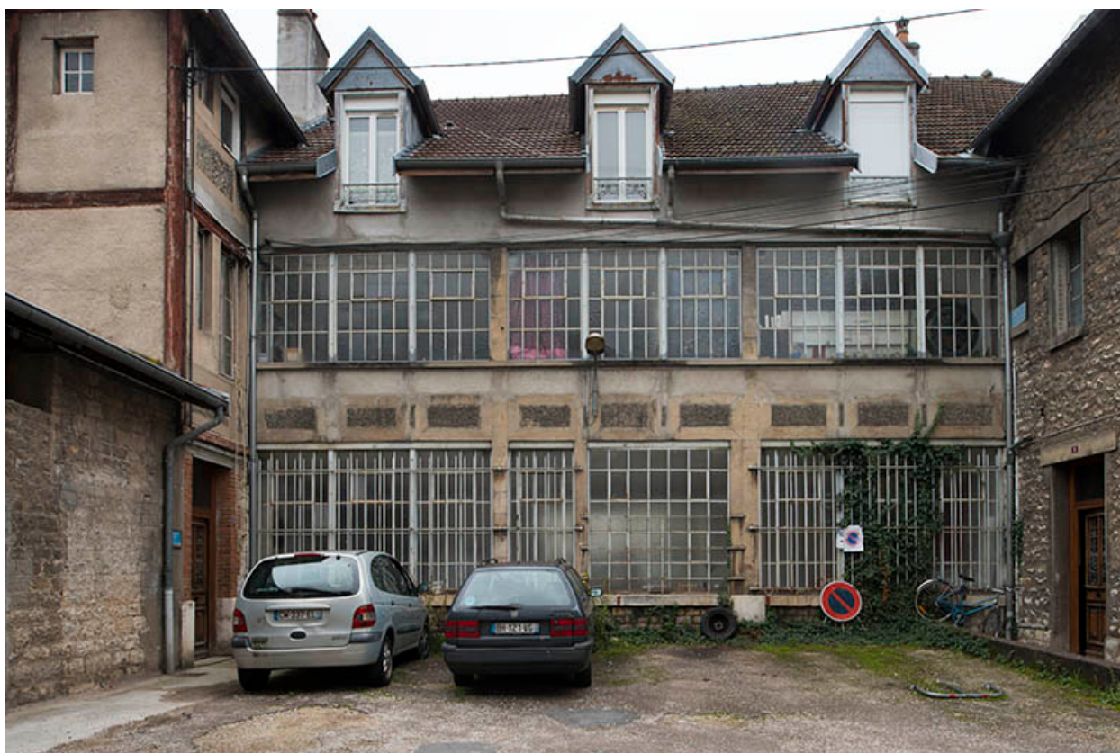
Façade nord d'un atelier de fabrication.
