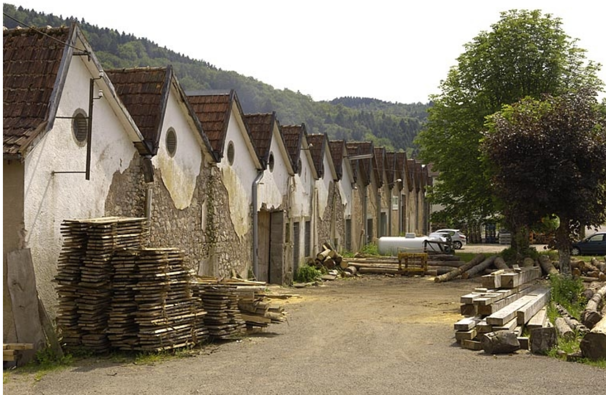
Pignons ouest de l'atelier de fabrication.
