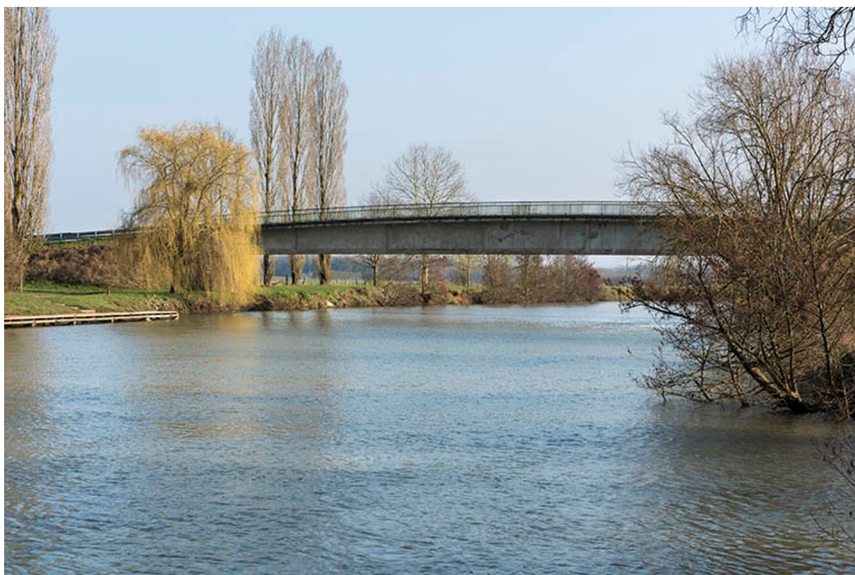
Franchissement de la Saône : pont de Fouchécourt.
